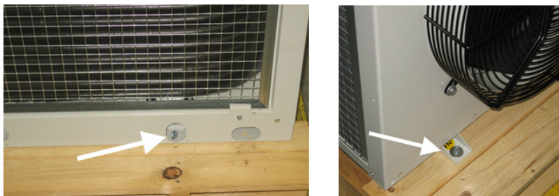
Fig. 7 Särskilda skruvlägen för fastsättning vid pallen på enheter utan tank
