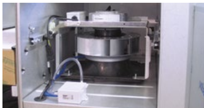
Direktdrivna fläktar med EC-motorer.
